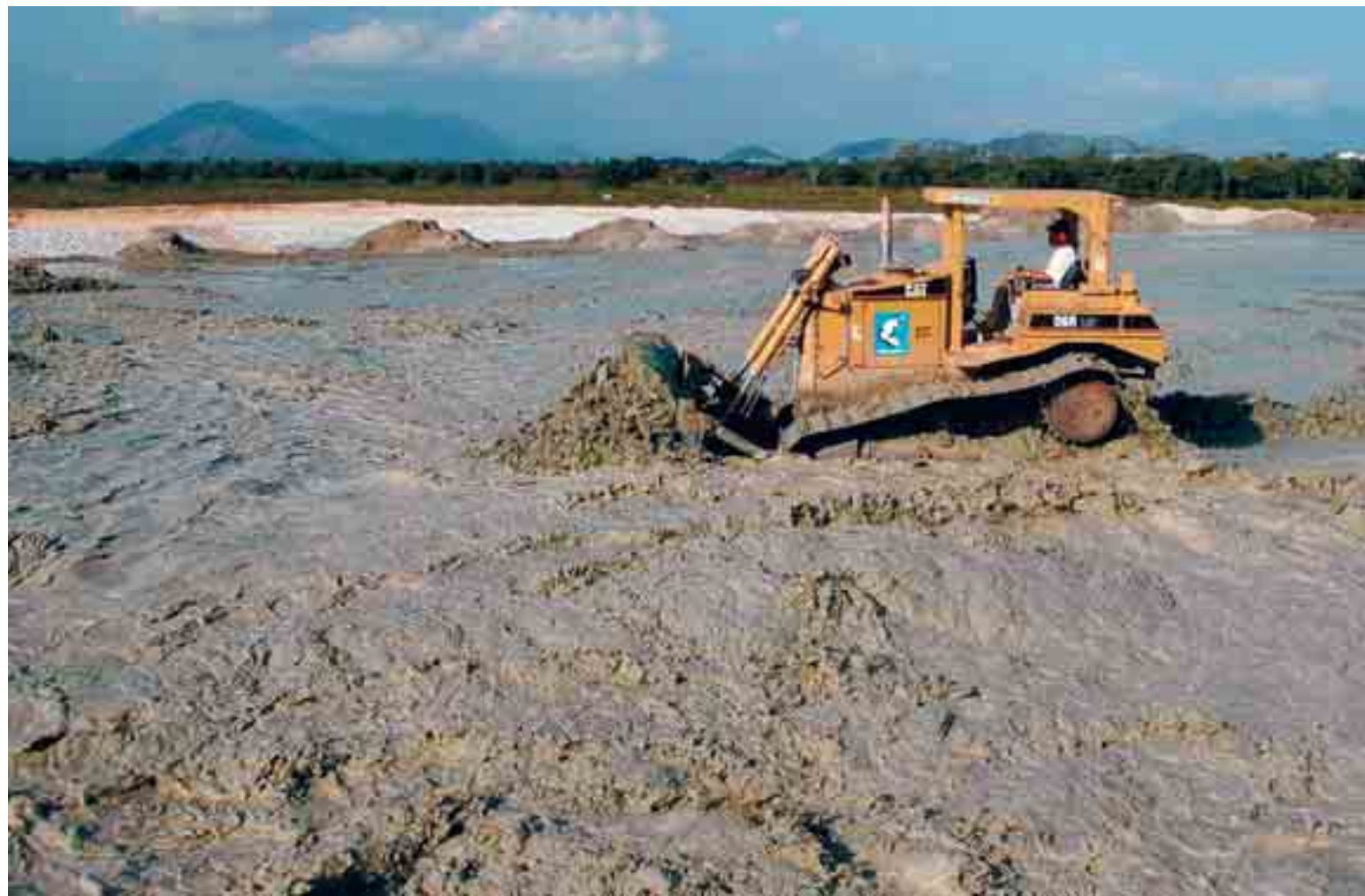
Het aangevoerde slib moet gelijkmatig verspreid worden over het bekken. © rr
