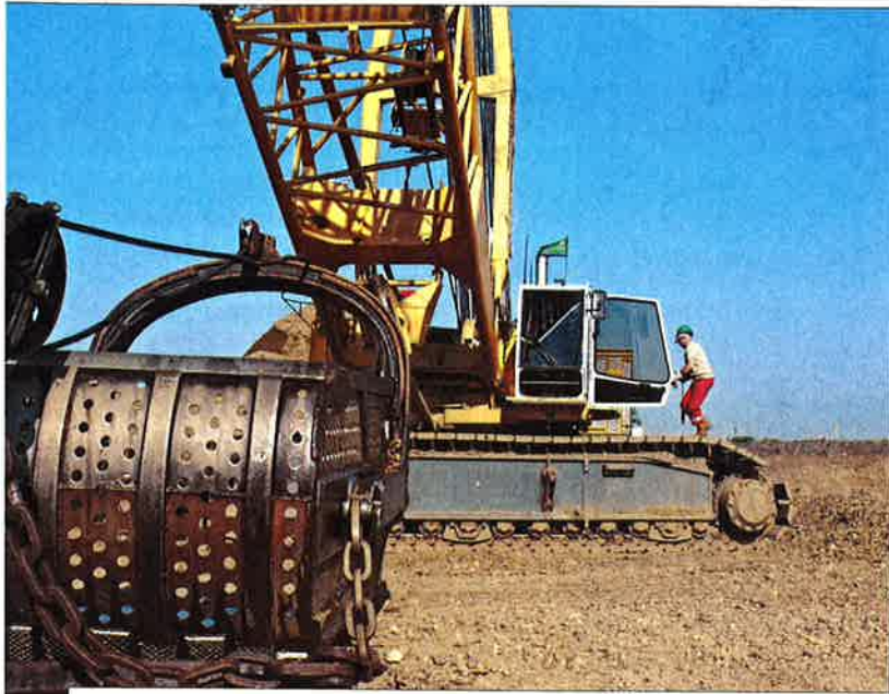
LAADBAK – De kabelkraan kan in één beweging tot vier kubieke meter toutvenant bovenhalen.
