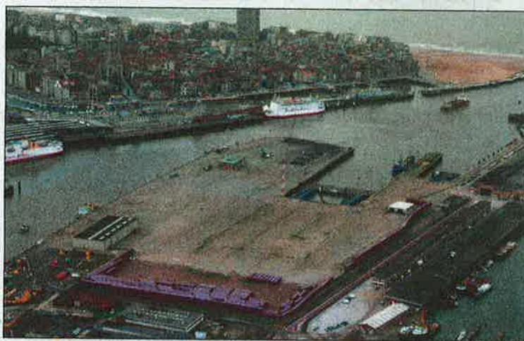
De vroegere roro-terminal krijgt de nodige kaaien om zeer zware lasten te laden en te lossen. © Henderyx
