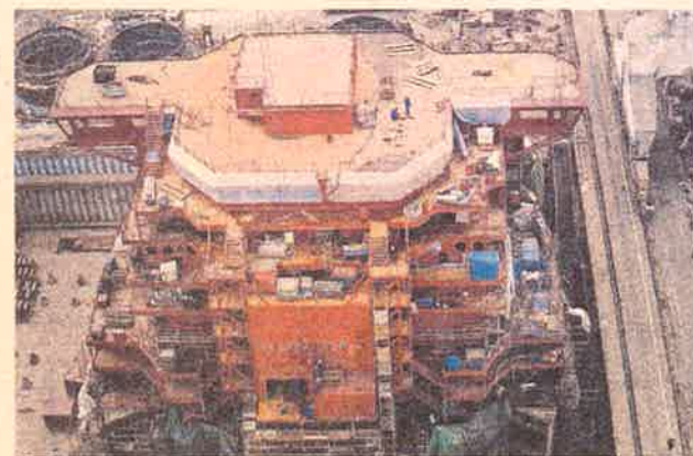
In het droogdok worden de stalen blokken aan elkaar gelast.
